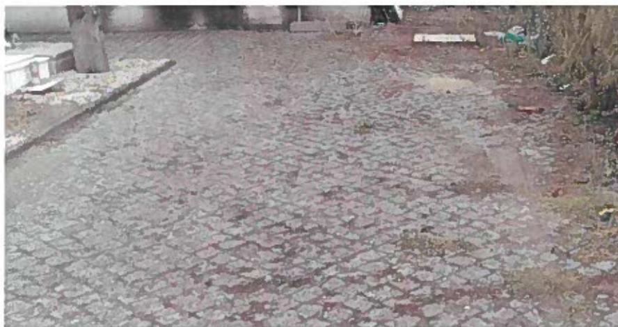
Fotografia 1 – Arruamento existente em calçada de cubos de granito
